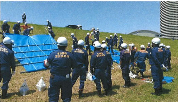
下：シート貼り工法 訓練
