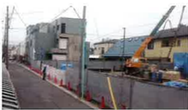
＜い打ちが始まる工事現場＞
